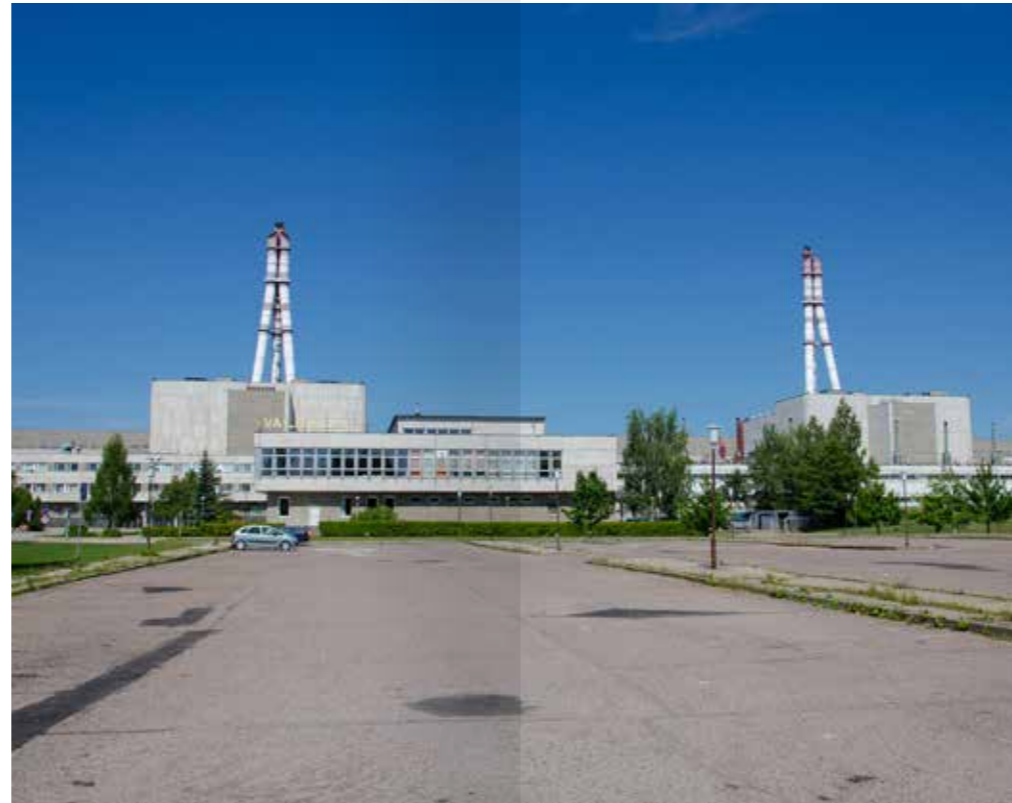
Ignalińska Elektrownia Jądrowa, widok ogólny.
