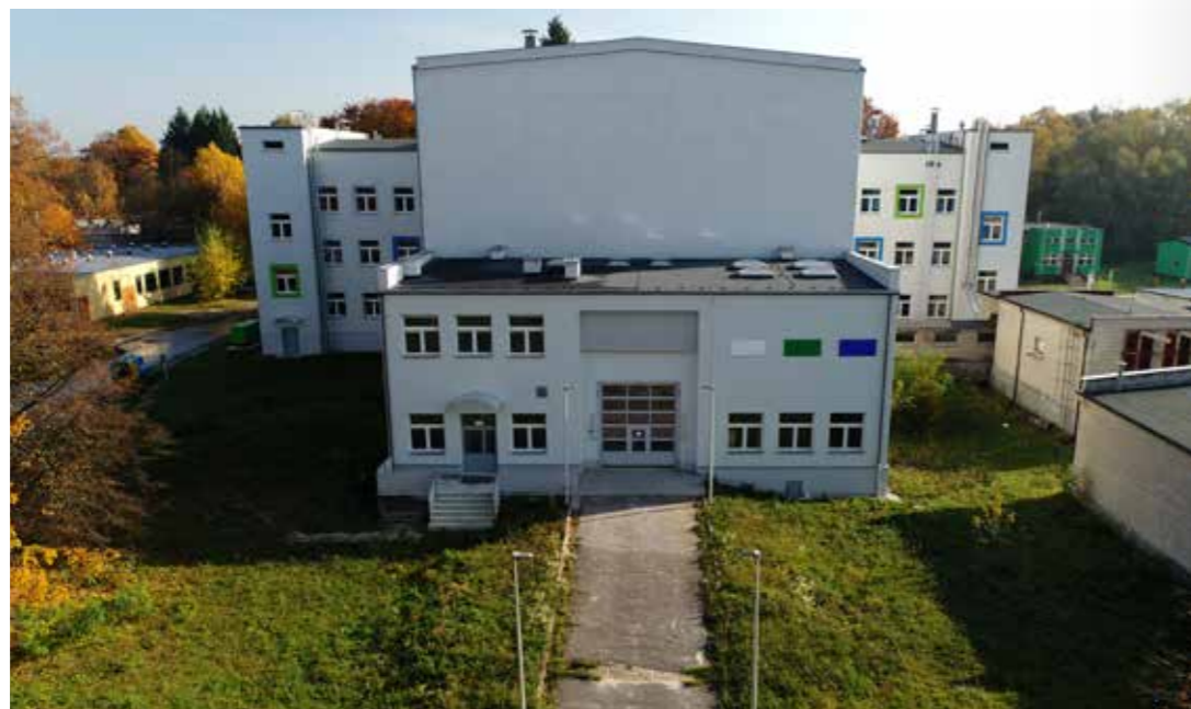
..... Budynek Zakładu Unieszkodliwiania Odpadów Promieniotwórczych , w Otwocku (Świerk). .....
