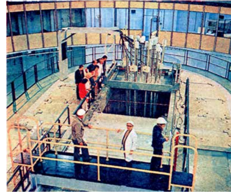
Reaktor Maria w czasie budowy Foto: Domena publiczna, https://commons.wikimedia.org/w/index.php?curid=132105
